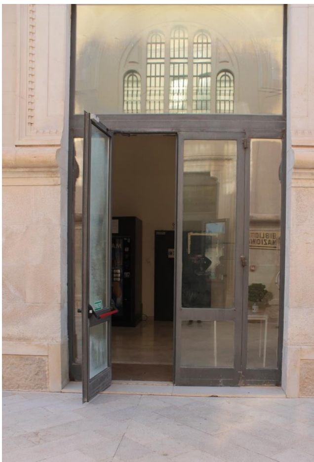
Foto n. 12 – Porta d'ingresso edificio ex Mercato Ittico
