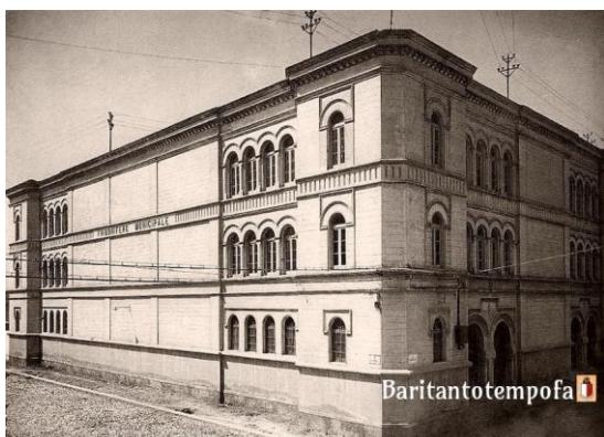
Figura 1 – Foto storica edificio “Frigorifero”
