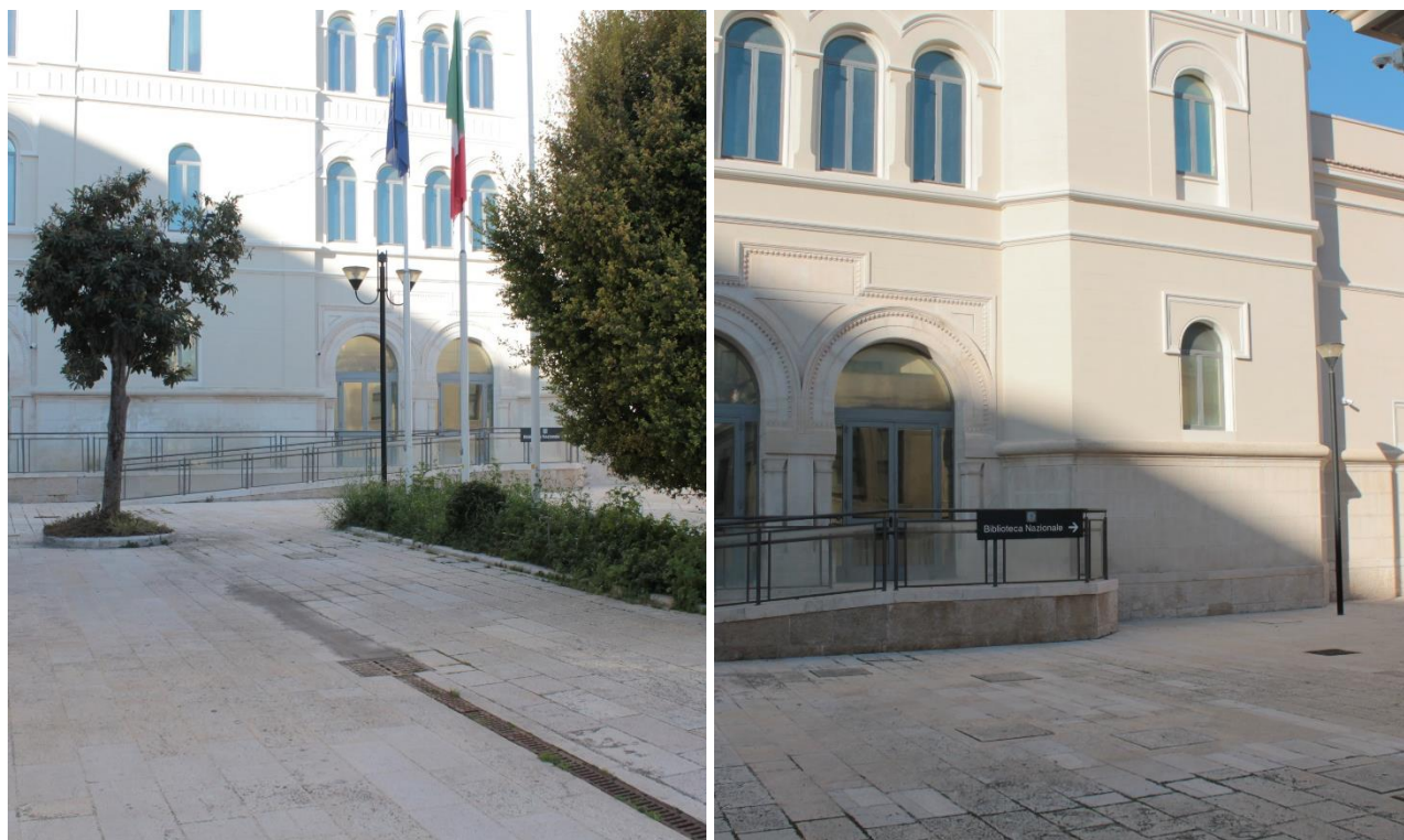
Foto n. 5 – Area interna alla Cittadella posta tra l'Archivio di Stato e la Biblioteca Nazionale
