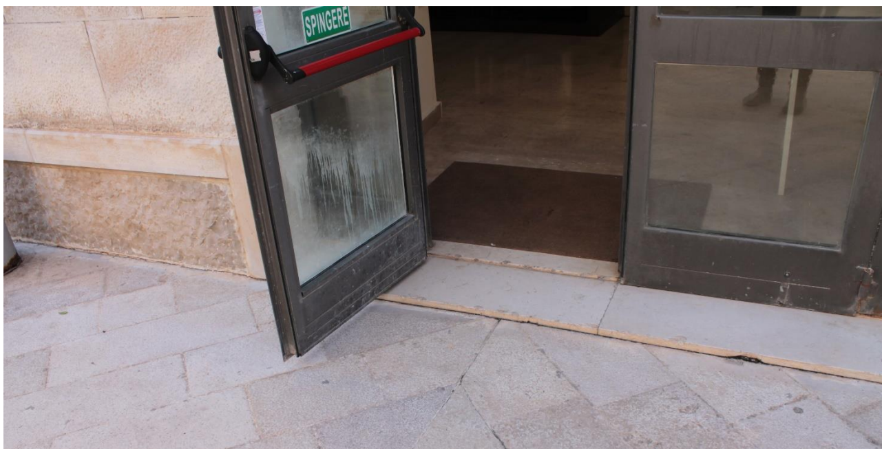
Foto n. 10 – Dettaglio soglia porte d'ingresso
