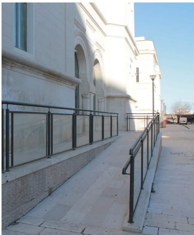
Foto n. 8 – Rampa accesso edificio ex Frigorifero
